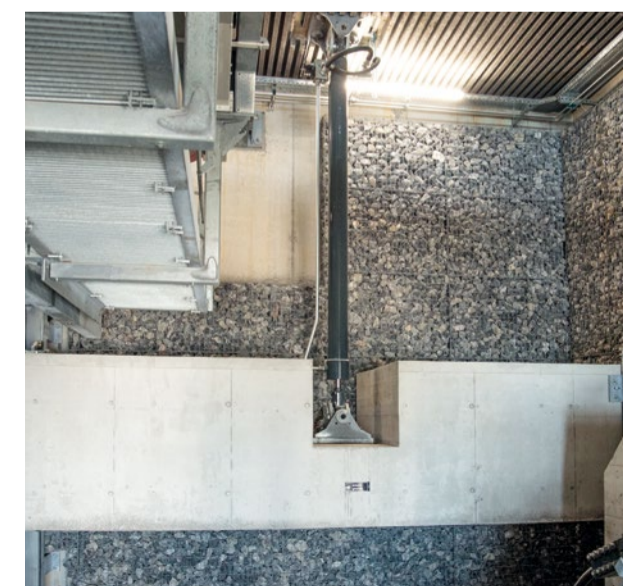
40t Arbeitsgewicht zur Energiespeicherung.
