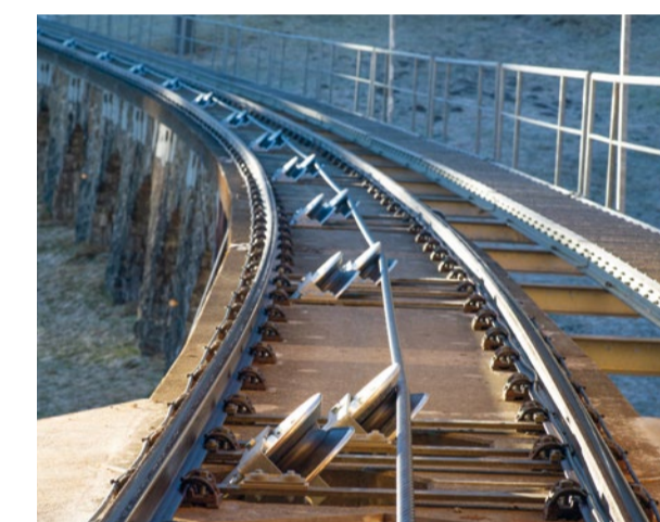
Sämtliche Streckenrollen, in Summe 300, wurden ausgetauscht.
