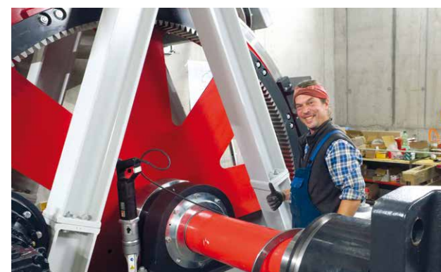
29. September 2016: Endarbeiten Antrieb
