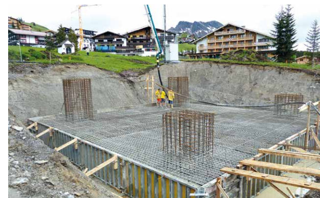
13. Juni 2016: Fundamentierung Stütze 2
