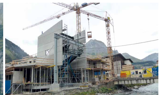
15. September 2016: Bauarbeiten Talstation
