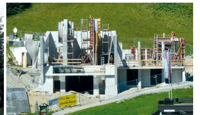
25. August 2016: Bauarbeiten Bergstation
