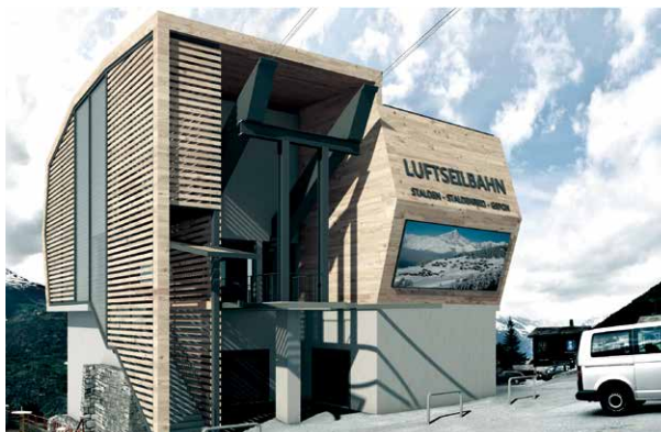
Die Mittelstation in Staldenried – Hier werden die Antriebssysteme der neuen Seilbahn untergebracht. Foto: © architektur + design, arnold perren zurniwen gmbh
