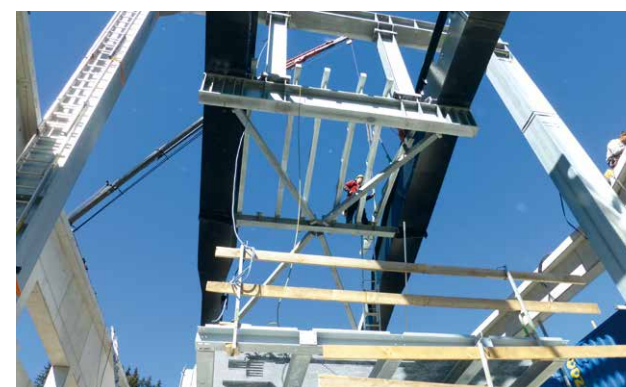
30. August 2016: Montage Bergstationsportal
